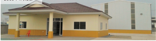
PPSEZ リサイクル工場 2019年8月竣工
